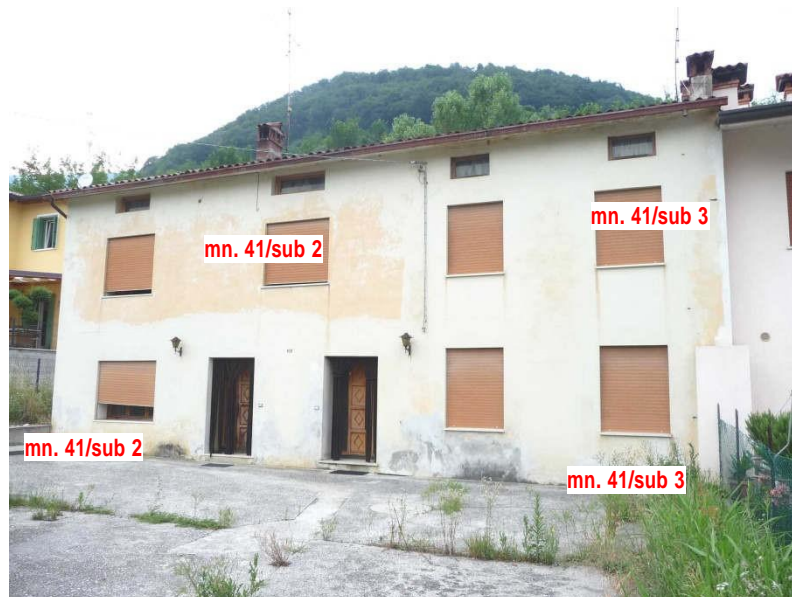
foto 02 (vista lato sud-est)
